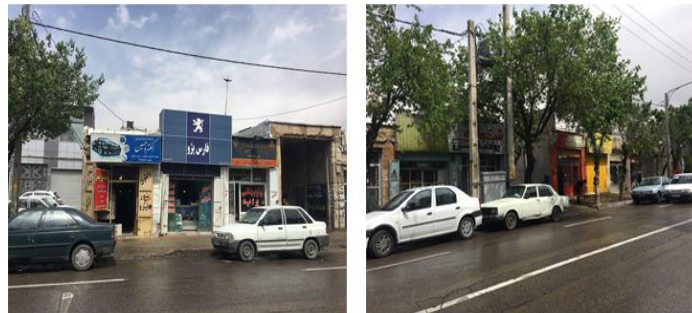
شکل 3- وضعیت خیابان حافظ و جداره‌های آن Fig.3-Hafez Street status and its frontages
