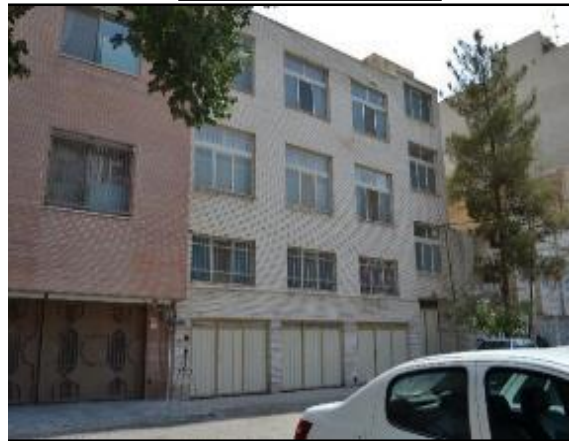
شکل 4 و 5 - ساختمان‌های واقع در بافت شبیه‌سازی شده Fig.4 and 5- Buildings located in simulated texture
