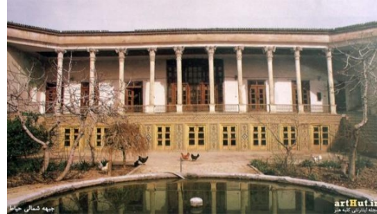
شکل 1- جبهه شمالی حیاط خانه لباف اصفهان
