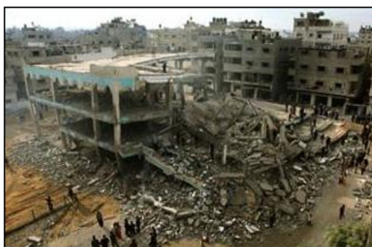
تصویر ۱۱- غزه-عدم انتقال فروریزش کامل سازه به بخش دیگر به دلیل استفاده از درز انقطاع
