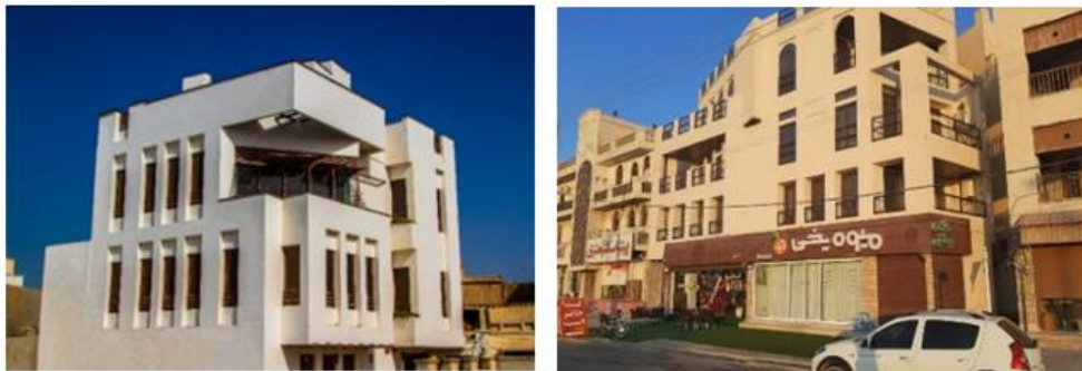
شکل 12- وضعیت موجود ساختمان A1 سمت چپ و A2 سمت راست
