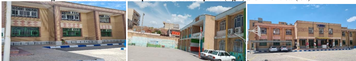
شکل 5- نمونه نماهای تیغه‌دار جنوبی در مدارس مسجد سلیمان Fig. 5- Some samples for the bladed southern facades of Masjedsoleiman's schools
