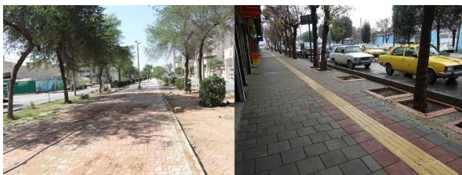
شکل 5- عدم بهره‌مندی از مبلمان مناسب در پیاده‌روهای شهر اهواز Fig. 5-Lack of proper furniture on the sidewalks of Ahvaz city
