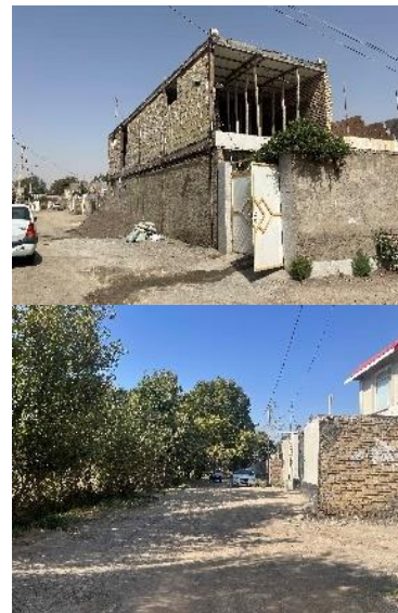
شکل 4- کیفیت پایین ساخت‌وسازهای جدید کوچه باغ‌ها Fig.4-Low-quality Construction in the Kucheh-bagh
