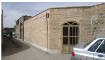
۳ مسجد و آب انبار قدیمی
