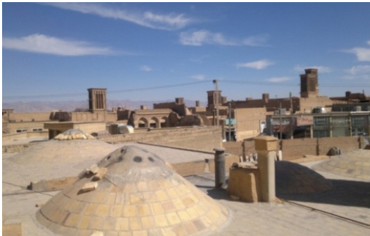
شکل ۱۱- سقف‌های گنبدی شکل
