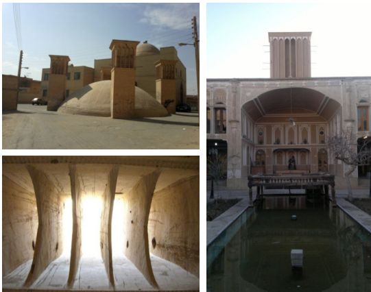
شکل ۱۳- استفاده از بادگیر در فضاهای مختلف در محلات در اقلیم گرم‌وخشک ایران
